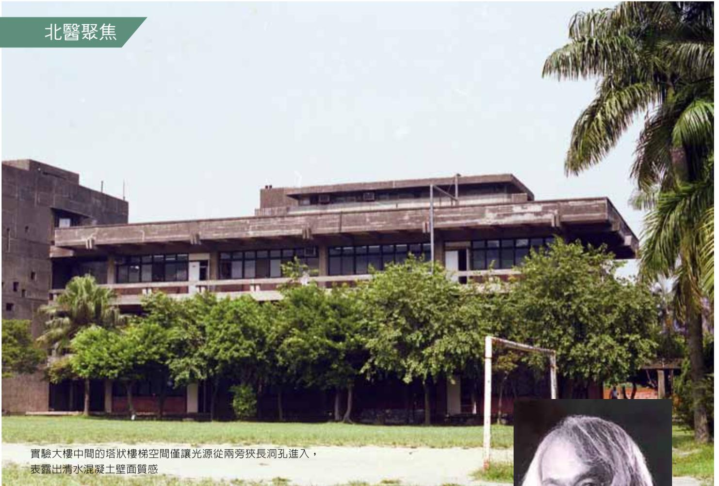
實驗大樓中間的塔狀樓梯空間僅讓光源從兩旁狹長洞孔進入，表露出清水混凝土壁面質感
