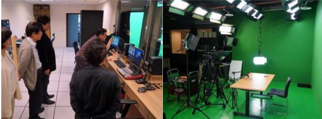
新建置的攝影棚包含專業的「虛擬攝影棚、副控室、錄音室和實景教室」等，由副控室控制攝影棚的燈光和聲音；透過攝影棚兩臺 Sony 4K 攝影機，將拍攝訊號傳遞至副控室；再經由副控室的數位虛擬導播機利用綠幕將人物去背，即時合成各種素材和影音訊號後，輸出錄製最後完成的畫面，並能支援現正熱門的「線上直播」模式。【圖：從副控室的數位虛擬導播機（左圖），可利用虛擬攝影棚的綠幕（右圖）將人物去背】
