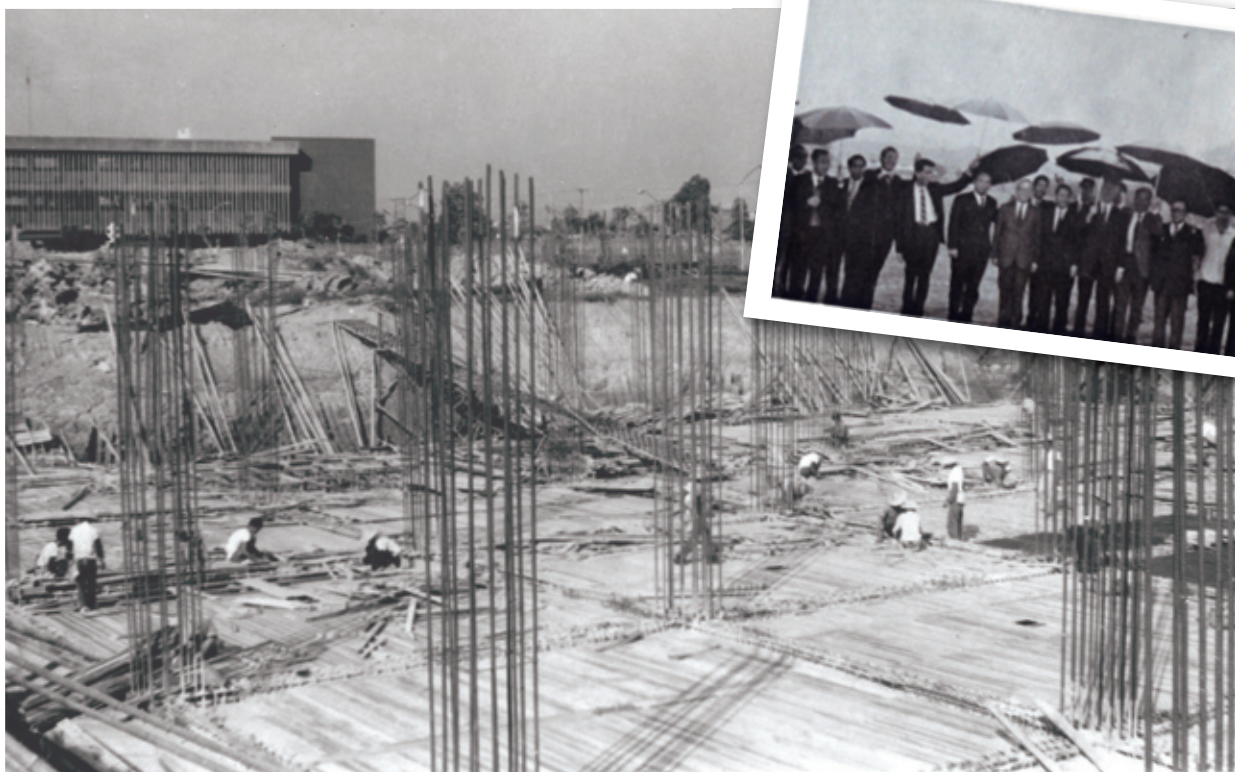
第一醫療大樓建築工地一景，右上為工程開工典禮
