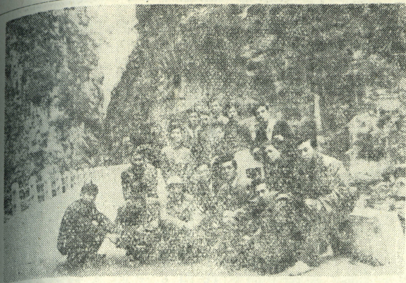
橫貫公路流芳橋上小憩
