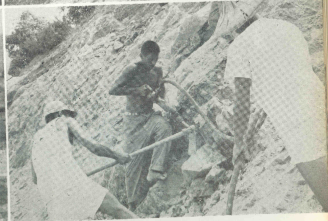
↑ 挖土工程之艱辛
