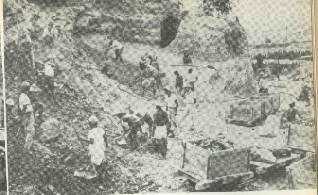
↑ 後山挖土移填校基
