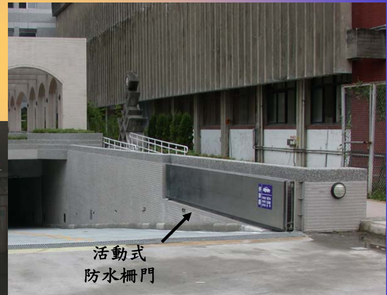
醫學綜合大樓 地下室入口
