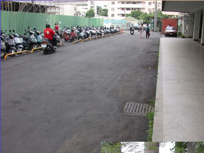
行政大樓 前方排水
