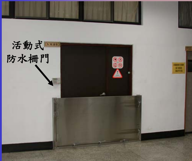
教研大樓 NMR室
